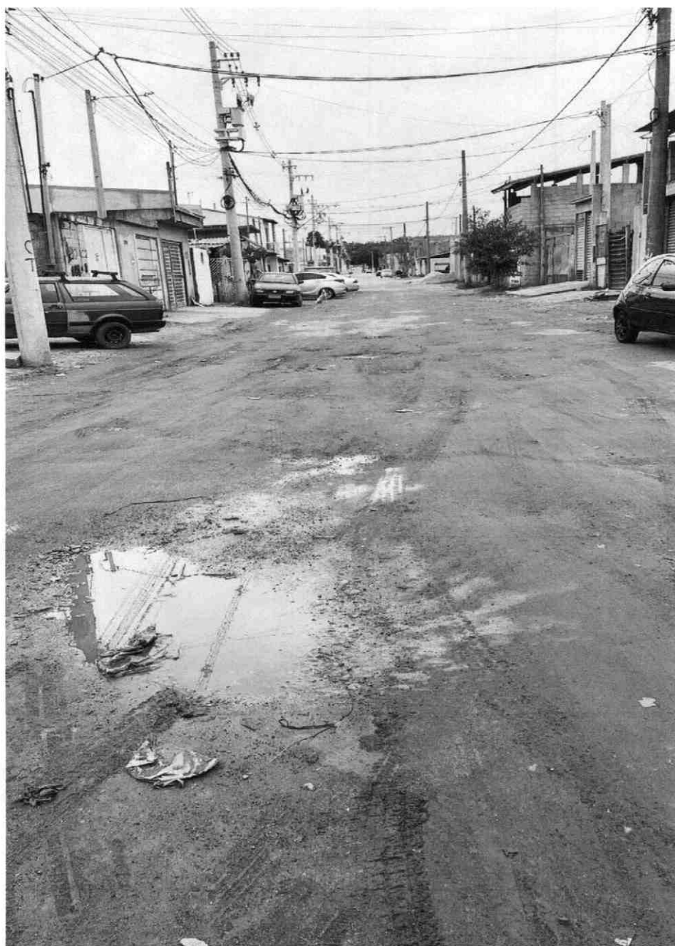
IMPLANTAÇÃO DE FRESA EM TODA A EXTENSÃO DA RUA OCEANIA, JARDIM AEROPORTO III – MOGI DAS CRUZES.
